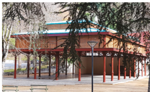
LA CRÉATION DE LA HALLE
