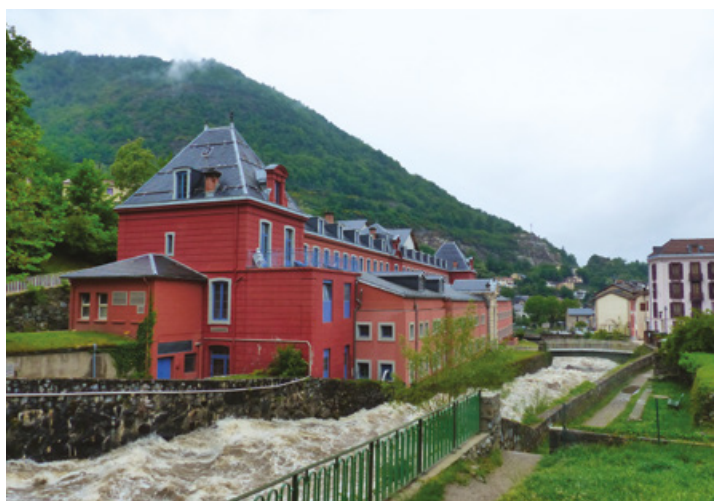
Rénovation de la façade arrière des menuiseries et du toit, agrandissement de l'avancée en bois, isolation et peinture de la façade. Revêtement coursive et abords. Signalétique dans le parc.
