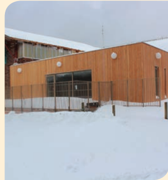
► Construction de la crèche à Bonasere
