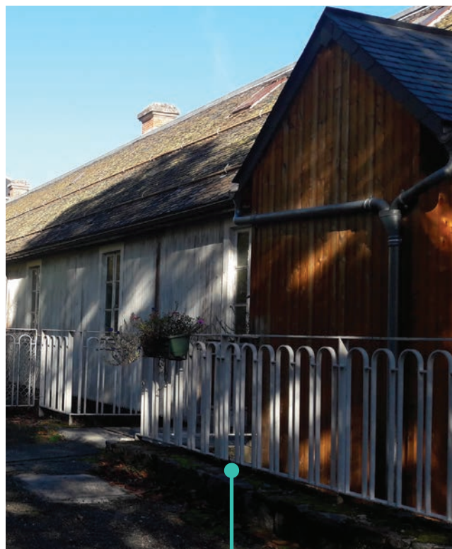
Partie du sol reliant la maison des curistes qui sera en enrobé couleur « automne »
