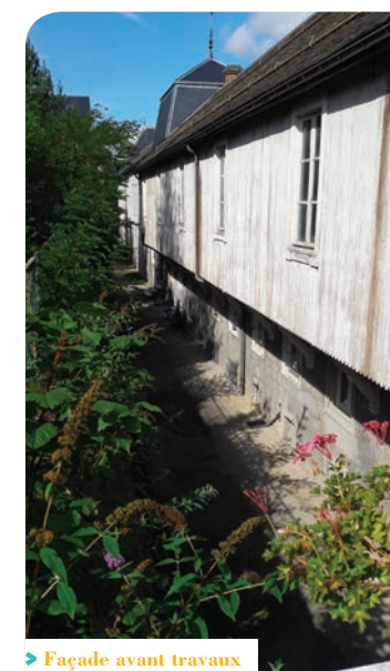
➤ Façade avant travaux
