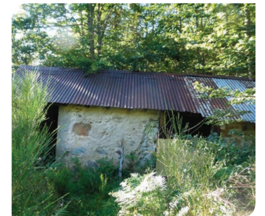
Cabane avant réhabilitation
